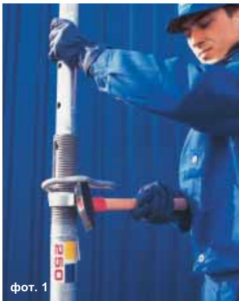
При распалубливании одним ударом молотка „перекручиваем” G-крюк вверх.
