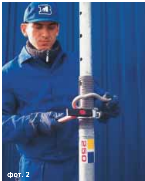
Произведен спуск оправки стойки и „освобождение” от нажима выполненного перекрытия. Теперь можно легко опустить оправку стойки при помощи L-крюка.
