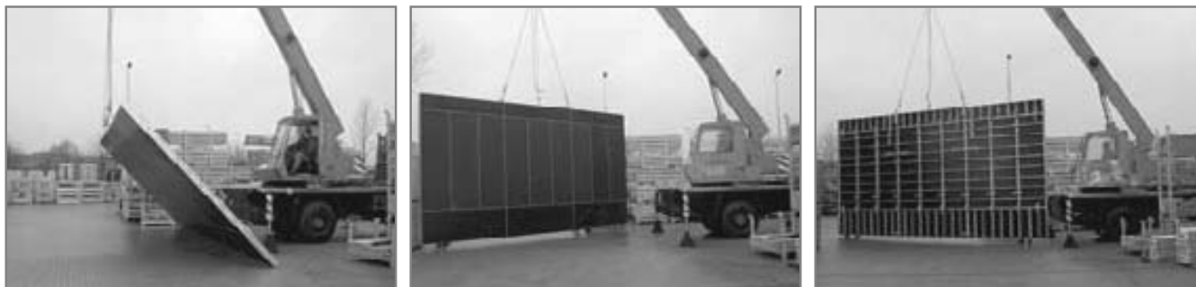
Примеры перемещения опалубочных плит при помощи крана
